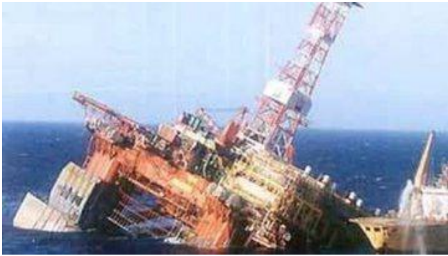
Рис. 8.11. Крушение буровой платформы «Кольская» в акватории Охотского моря
