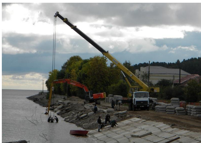
Рис.6.25. Ремонт дамбы в г. Юрьевце Ивановской области
