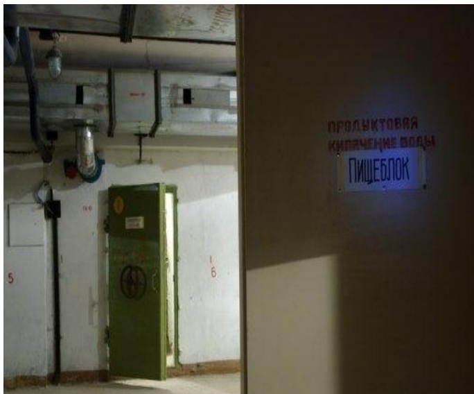
Рис. 6.26. Защитное сооружение ГО
