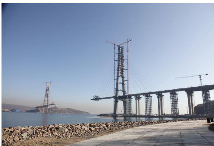
Рис. 5.23. Строительство моста на о. Русский
