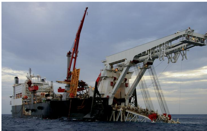
Рис. 5.25. Строительство газопровода «Северный поток»
