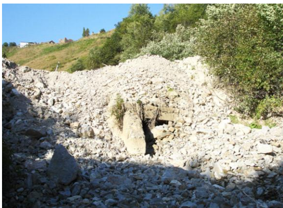
Рис. 1.30. Селепропуск, забитый и деформированный селевым выбросом
